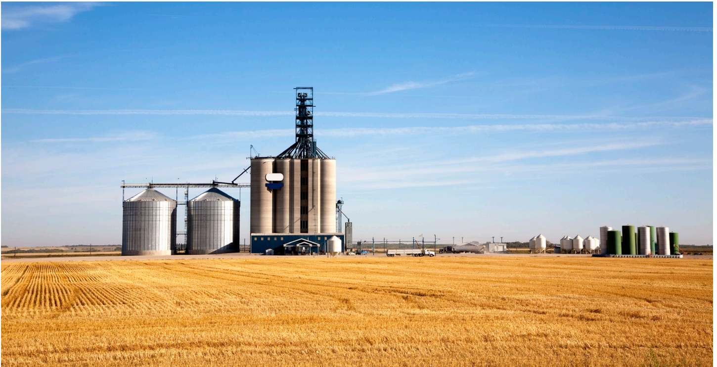
Silo à céréales au Saskatchewan
